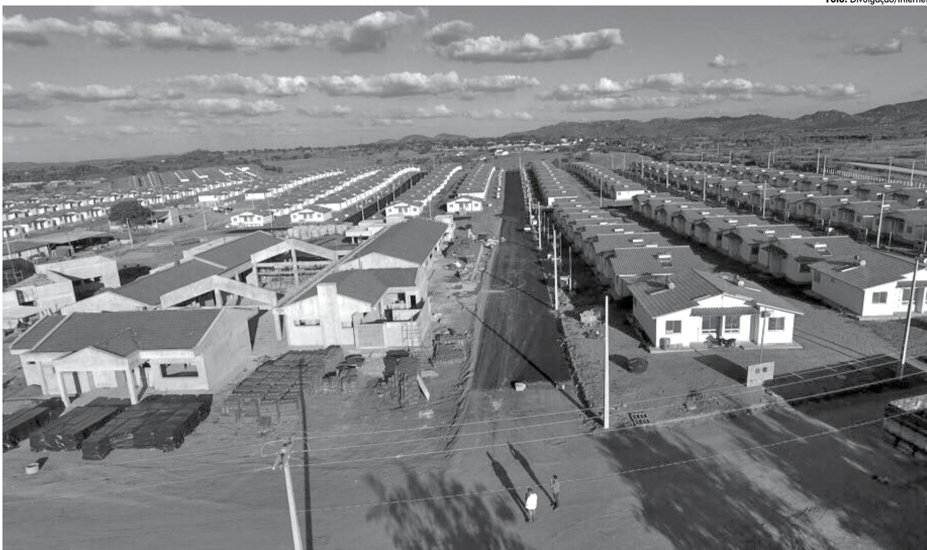
Unidades residenciais quando estavam em construção na cidade de Campina Grande, na Paraíba, todas dentro deste programa com os financiamentos advindos do Governo Federal
